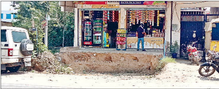
नारनौल। सड़क किनारे दुकान के सामने खुदाई का एक नमूना।
